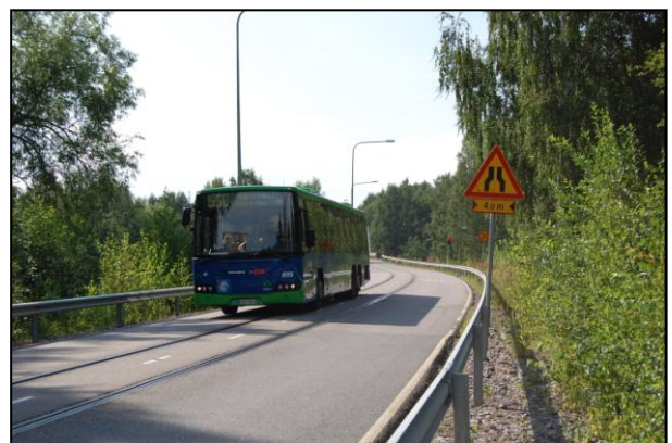
Kuva 7. Vantaanjoen ylittävä silta on vain neljä metriä leveä.
